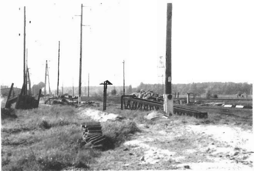
Abb. 4. Steinschmätzer-Biotop auf einer Baustelle. phot. Heinz Menzel
